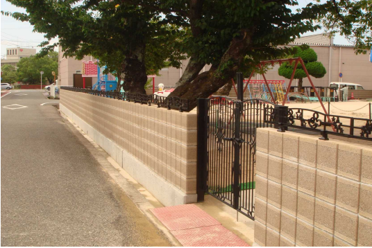
外壁ブロック・ミニフェンスが完成しました 8/28
